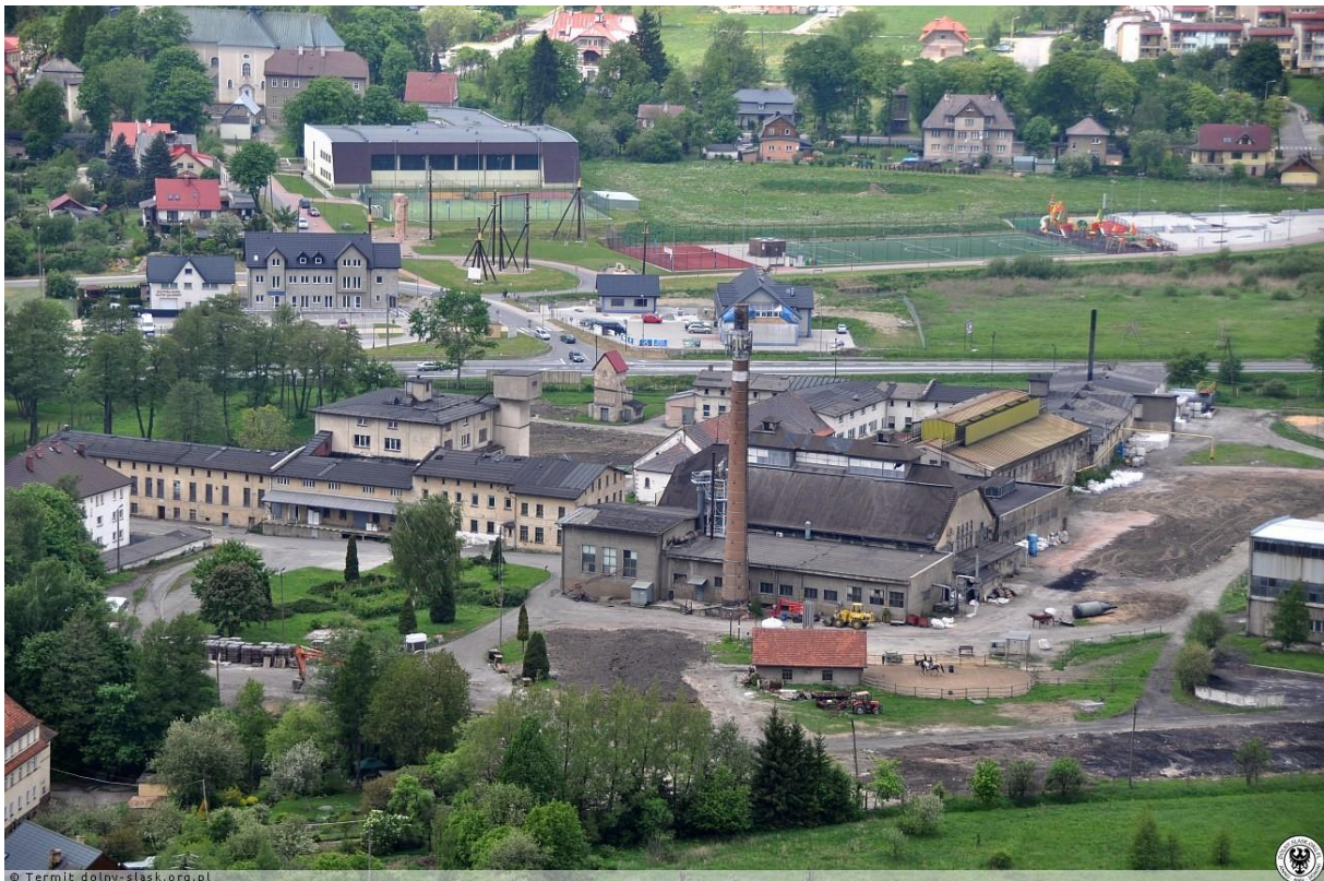
Fot. 4: Zabudowania huty szkła Sudety przed wyburzeniem 19
